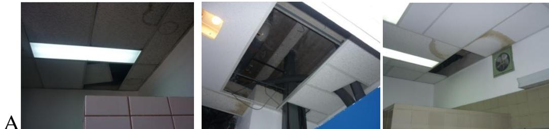
Luces quemadas: en pasillos y gradas hay faltante de luces y en algunas las que están se encuentran quemadas, se necesita el cambio de las mismas (B)
