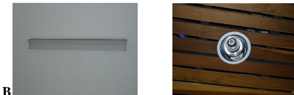
Ranuras de ventilación: estas ranuras se deben analizar por parte del arquitecto ya que por las mismas en momentos lluviosas ingresa el agua en gran cantidad inundando el III piso (C).
