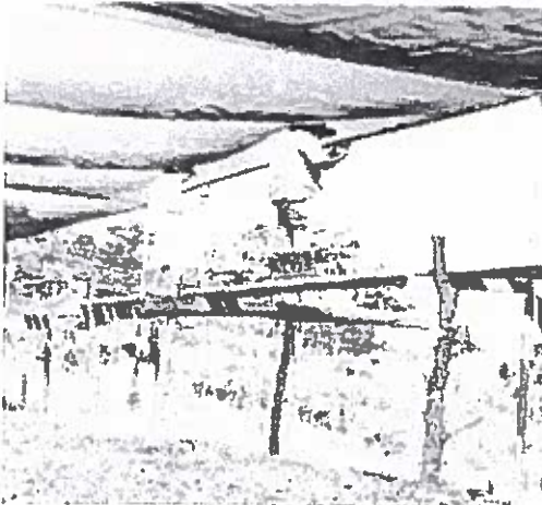
Instalación de casa sombra para producción de Hortalizas en Santa Elena
