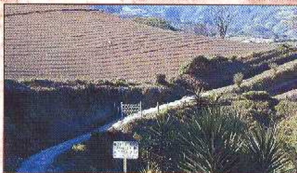
Buenas prácticas de preparación de suelo y obras físicas.
