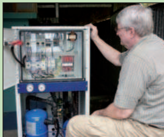
Ing. Phillip Ausburn, instalando la Unidad de Frío.
