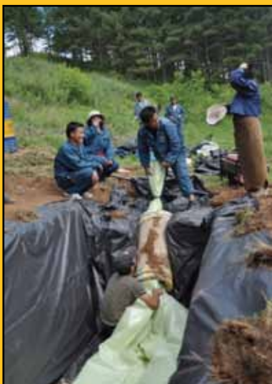
Foto 12. Traspaso de la bolsa entre las alcantarillas a cada extremo.
