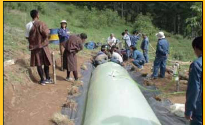
Foto 15. Una vez inflada la bolsa se procede a llenarla de agua hasta establecer el sello de agua, que ocurre cuando se alcanza un nivel que sobrepase unos 20 cm sobre el borde superior de las alcantarillas
