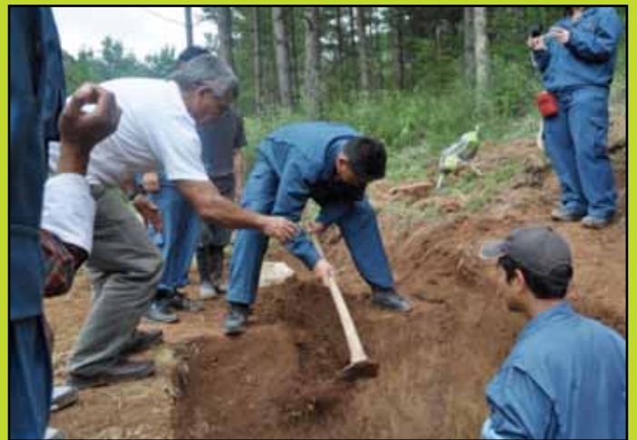
Foto 3. Hechura de los lugares donde se asientan las alcantarillas en los dos extremos del biodigestor, las cuales servirán, en uno como recibo de las excretas y en el otro como salida del efluente.
