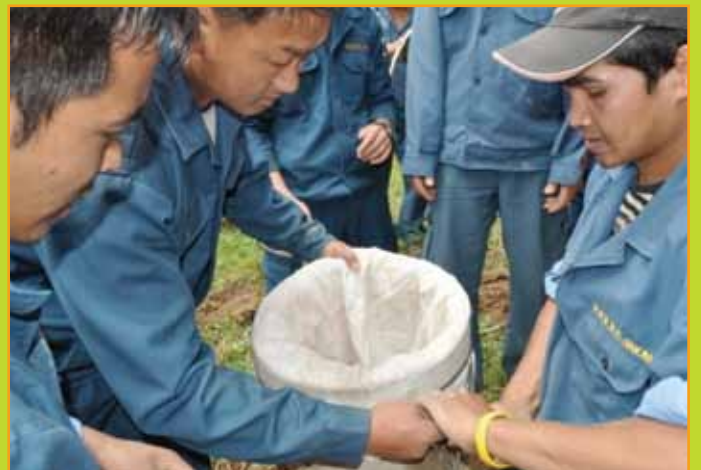
Foto 4. Forrado de las alcantarillas antes de colocarlas, para proteger la bolsa plástica de daños por efecto del filo de los bordes.
