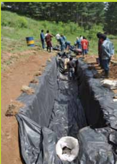
Foto 7. Colocación de las alcantarillas sobre el plástico y sobre el bloque de cemento el cual quedó cubierto por el plástico negro.
