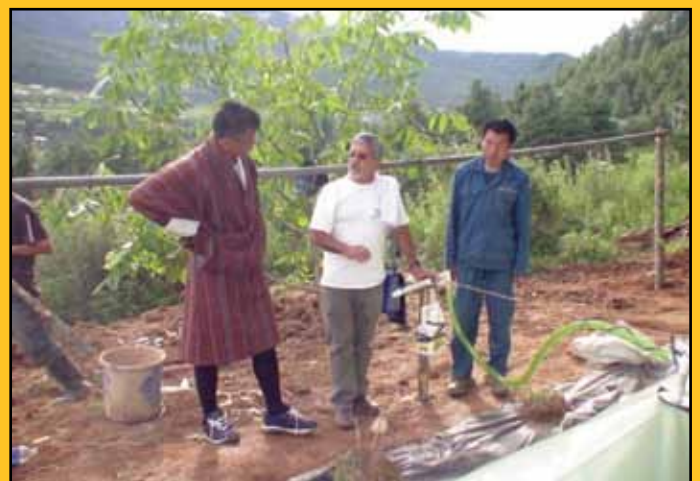
Foto 16. Instalación final de la bolsa tubular, con sello de agua, válvula de seguridad y armazón del techo que protegerá el biodigestor de la lluvia, el sol y daños por animales o personas.
