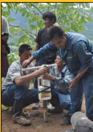
Foto 13. Instalación de la válvula de seguridad del biodigestor y de donde se conecta la tubería de PVC hacia el punto de consumo.
