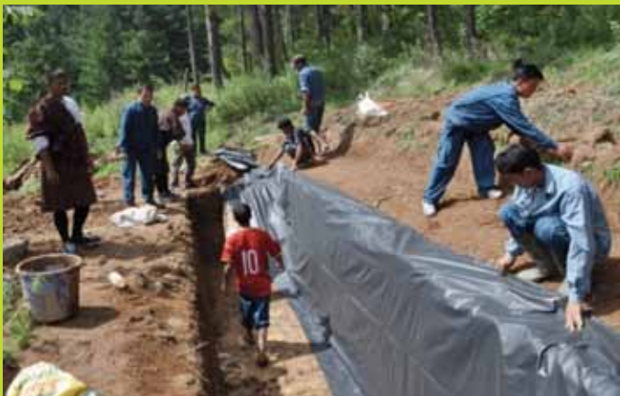
Foto 6. Colocación de plástico para aislar al biodigestor de la humedad del suelo opcional si la tabla de agua es muy superficial.
