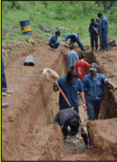
Foto 5. Colocación de bloques de cemento donde se asentarán las alcantarillas para que no se hundan en la tierra y vayan a dañar la bolsa plástica
