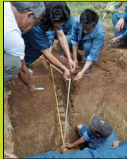
Foto 2. Marcado de la pendiente de 45° y centrado del trazo donde se instalarán las alcantarillas que servirán de entrada de suministro de excretas y de salida del efluente del biodigestor.
