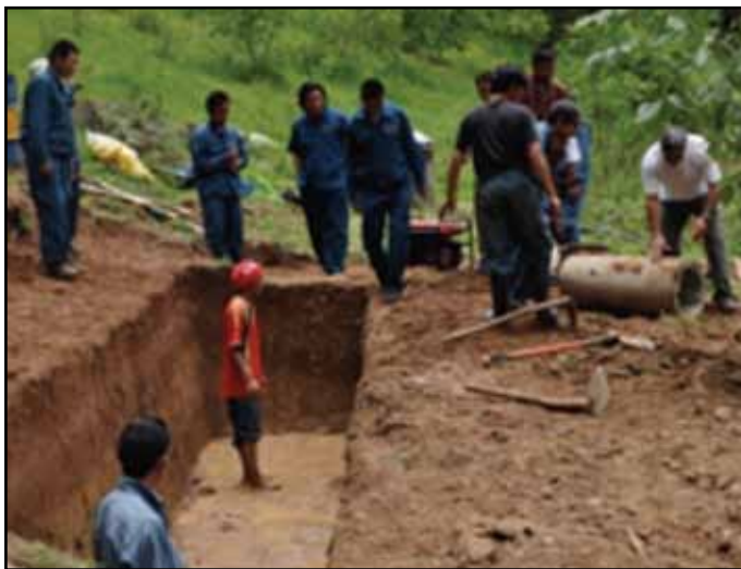
Foto 1. Construcción del hueco donde se instalará el biodigestor cerca de la fuente de excretas y del centro de consumo de energía (no más de 200 metros).
