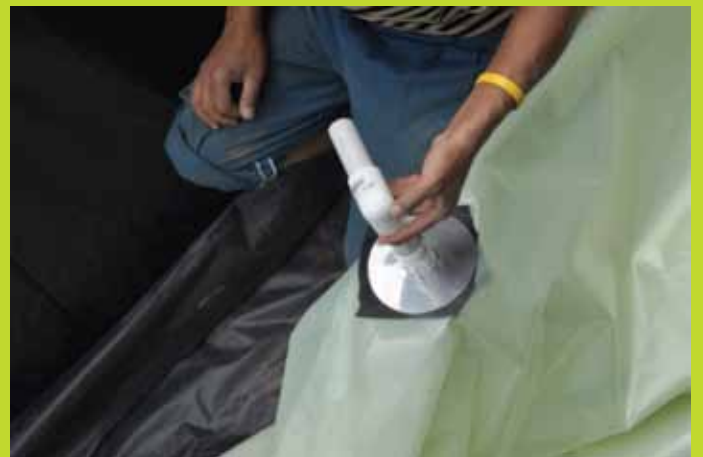
Foto 10. Colocación de la válvula de salida del biodigestor, la cual consta, desde el interior de la bolsa, de un empaque de hule para proteger el plástico, una arandela rígida de metal y una unión macho de pvc, que atraviesa la bolsa plástica del interior al exterior, desde donde es recibido por un juego similar de empaque de hule, arandela y ahora una unión hembra de pvc.
