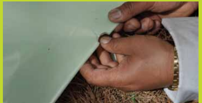
Foto 9. Corte de la doble bolsa en el centro de una de las orillas en donde se ubicará la válvula de salida del biodigestor.
