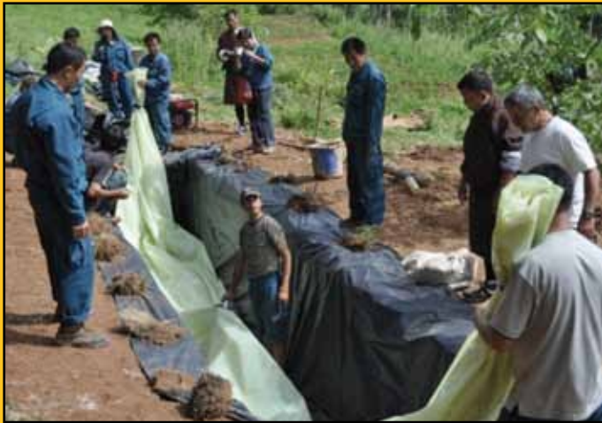
Foto 11. Transporte y colocación de de la doble bolsa plástica en el hueco del biodigestor.
