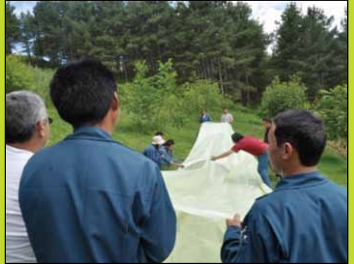
Foto 8. Preparación de la doble bolsa plástica extendiéndola sobre una superficie plana y libre de objetos punzocortantes que puedan dañarla. El plástico tubular, originalmente, es de una sola capa, por lo que la doble bolsa hay que prepararla comprando suficiente, cortándola en dos e introduciendo una dentro de la otra, lo que asegura una mayor resistencia y vida útil del biodigestor (10 años)
