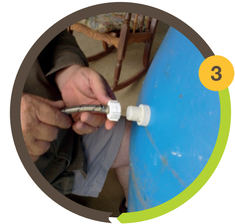
Figura 3: Acoplando la manguera de abasto.
