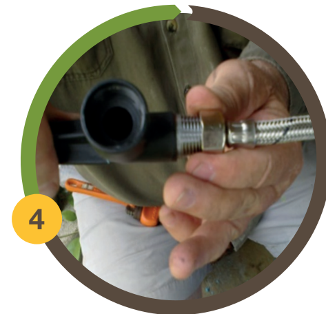
Figura 4: Acople de manguera de abasto y estaca plástica.
