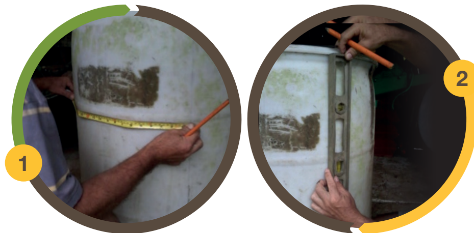
Figuras 1 y 2: Marcado de estañón para hacer puerta móvil. Las líneas verticales deben de ser aplomadas con el nivel.
