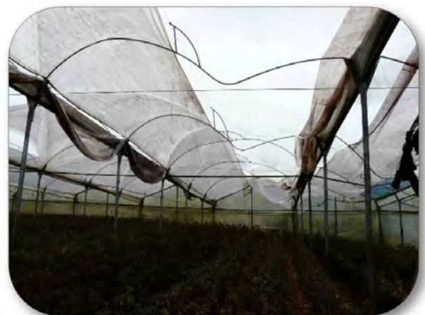
Daño por viento causado principalmente por un error constructivo. Arcos muy débiles para soportar la presión del viento. Nótese que el plástico no tiene daño
