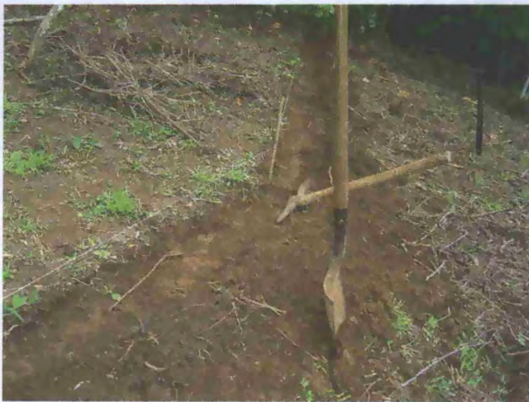
FIGURA 8: Obras de conservación de suelo
