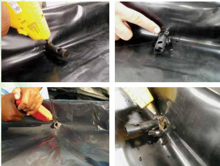
**Foto 12.** Sellado del drenaje en el punto de contacto entre el plástico y la manguera.
