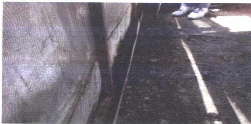
Foto 14 Canal que recolecta los lixiviados o purín de lombriz
