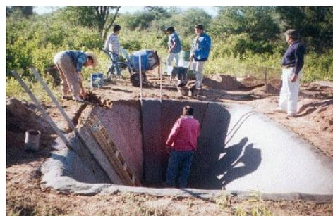
Figura 24: Construcción de tanque revestido con concreto. Fuente: Cajina 2006.
