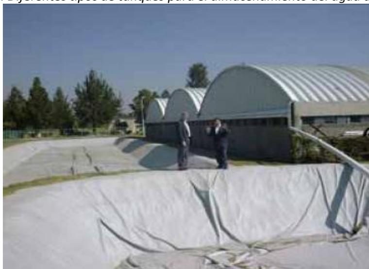
Figura 34: Impermeabilización de reservorio haciendo uso de geomembranas.
