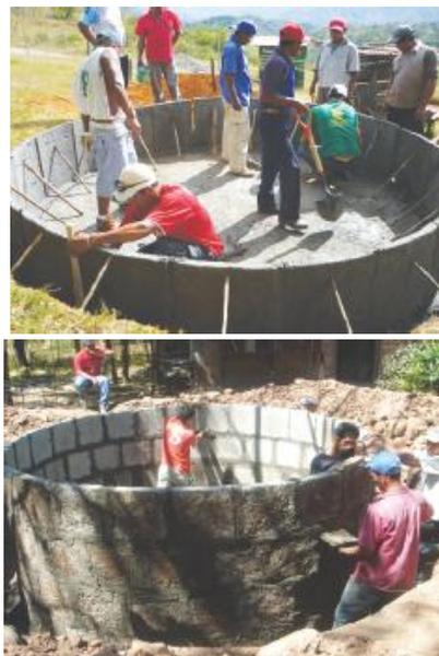
Figura 28: Diferentes etapas de construcción de tanque de almacenamiento de agua de lluvia. Fuente: Cajina 2006.
