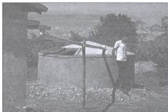
*Figura 16: Cisterna familiar hecha con placas de ferrocemento prefabricadas en Brasil.*
