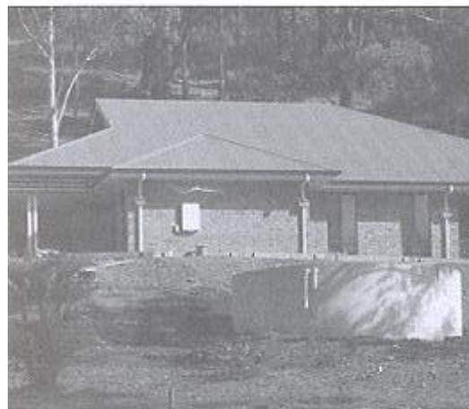
Figura 18: Captación del agua de lluvia en techos de lámina y conducción con canaletas en Nicaragua.
