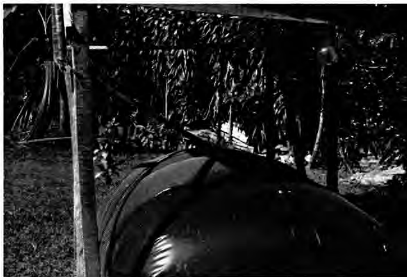
Biodigestor utilizado por pequeños poricultores para el manejo y aprovechamiento de desechos orgánicos.
