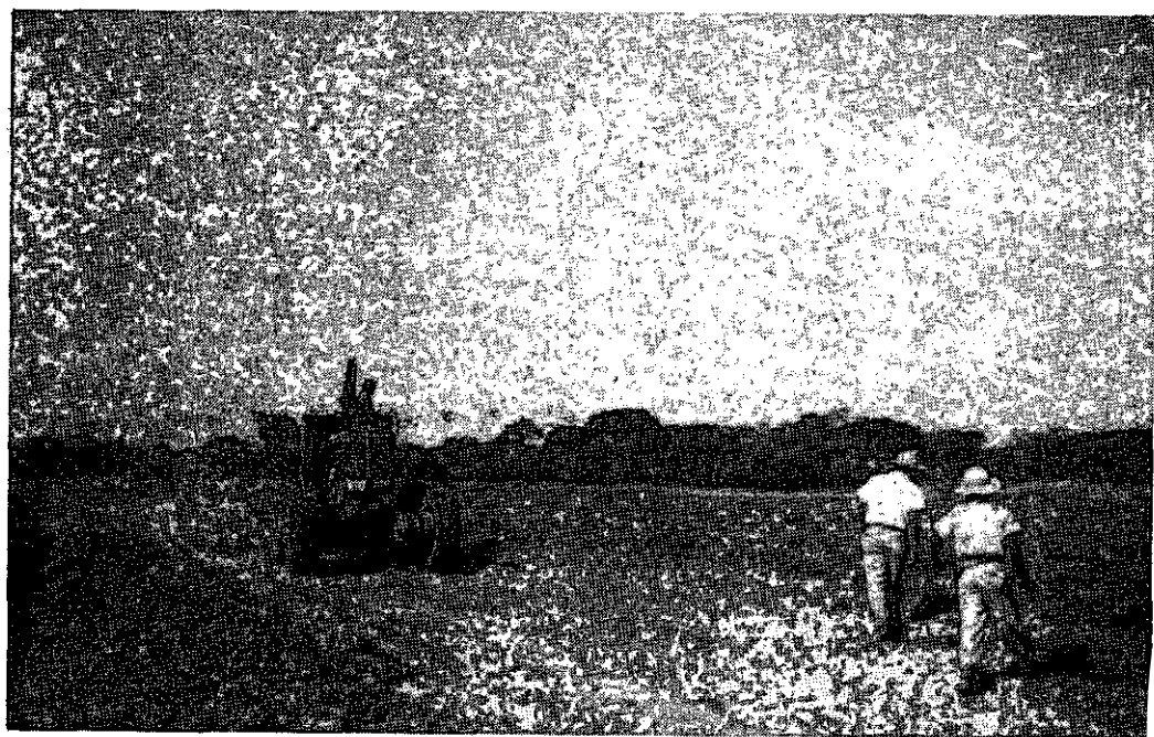
Foto 5:—Trabajando con maquinaria en la construcción del camino de Socorrito
