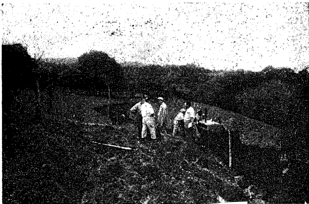
Foto 10:—La Fotografía muestra la construcción del camino en la Finca Los Jaules.
