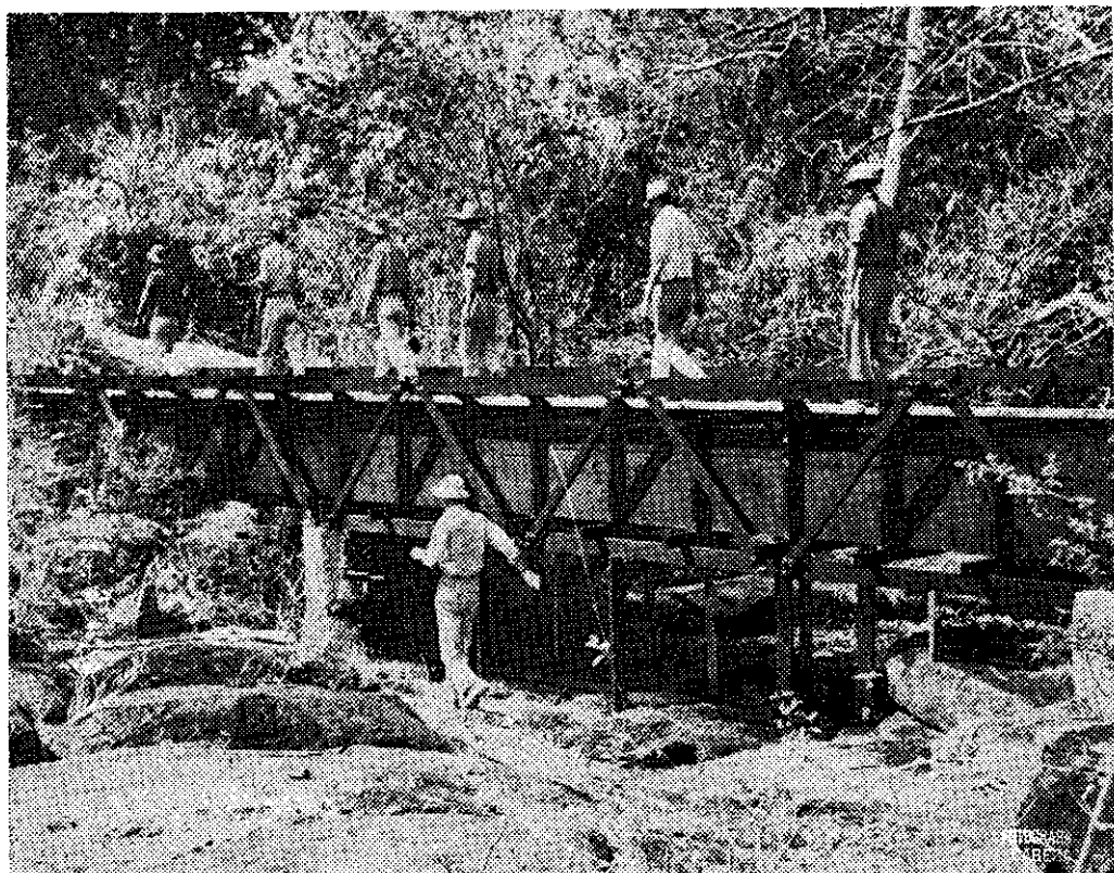
Foto N° 4.—Un acueducto de madera para salvar una depresión, construido como parte de un canal de derivación en un proyecto de irrigación en el Guanacaste.
