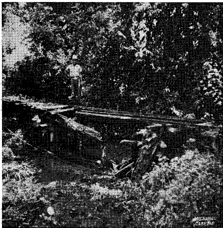
Foto Nº 5.—Trabajo de reparación de puentes en la finca La Rita.
