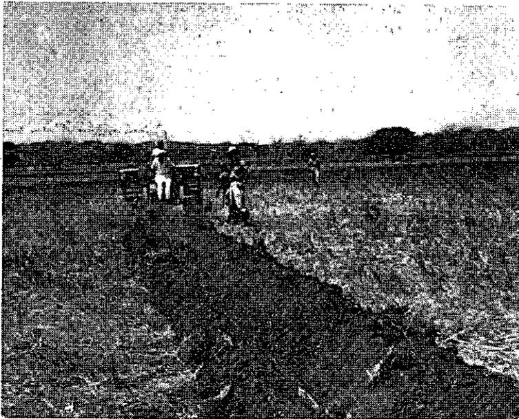
*En el Guanacaste, donde se están emprendiendo obras de irrigación en mayor escala, es frecuente el uso de maquinaria pesada para la construcción de los canales. Siguiendo las estacas puestas por los Ingenieros, un tractor equipado con zanjador construye uno de esos canales.*
