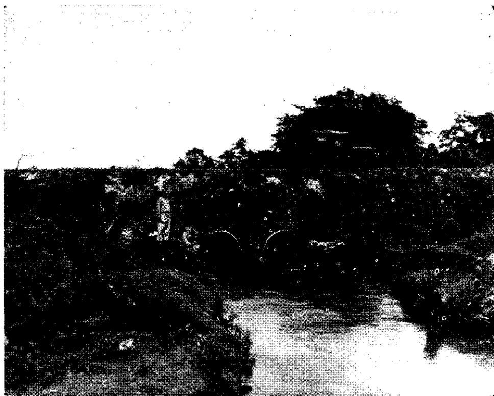
*Vista del cruce de la Carretera Interamericana con el canal de riego trazado por el Departamento de Ingeniería de STICA en la finca Paso Hondo de Cañas, Guanacaste. Este canal carga 1.500 litros por segundo y tiene 4.500 metros de longitud.*
