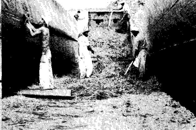
Construcción y forrado impermeable de un silo de cojón para el almacenamiento del exceso de pasto.
