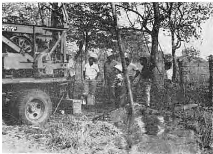
Equipo de perforación para aprovechamiento de aguas subterráneas.
