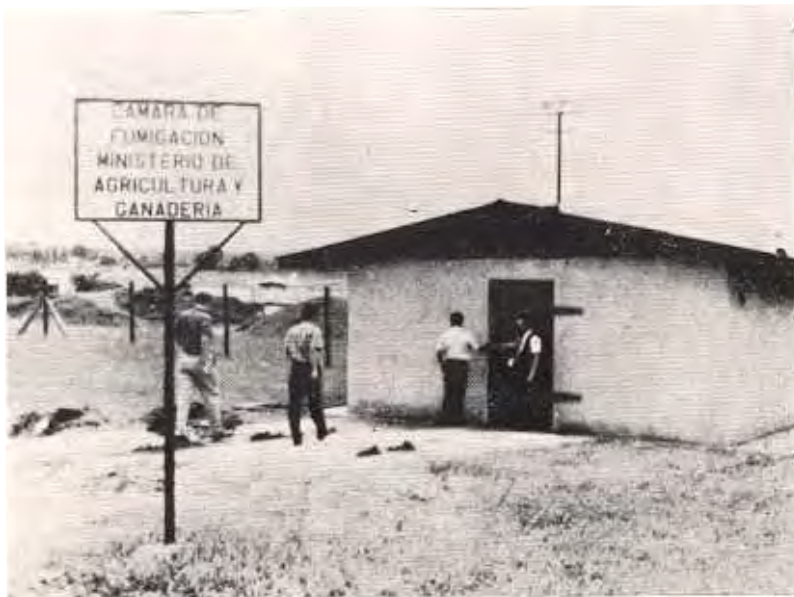
Cámara de fumigación, Aeropuerto El Coco.
