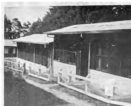
Nuevas Instalaciones del laboratorio
