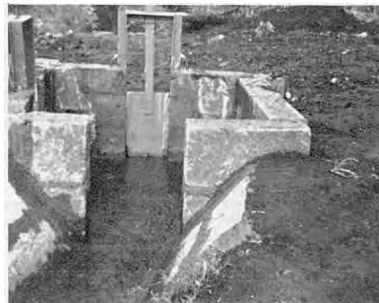
Caja de distribución de agua de riego a nivel de parcela
