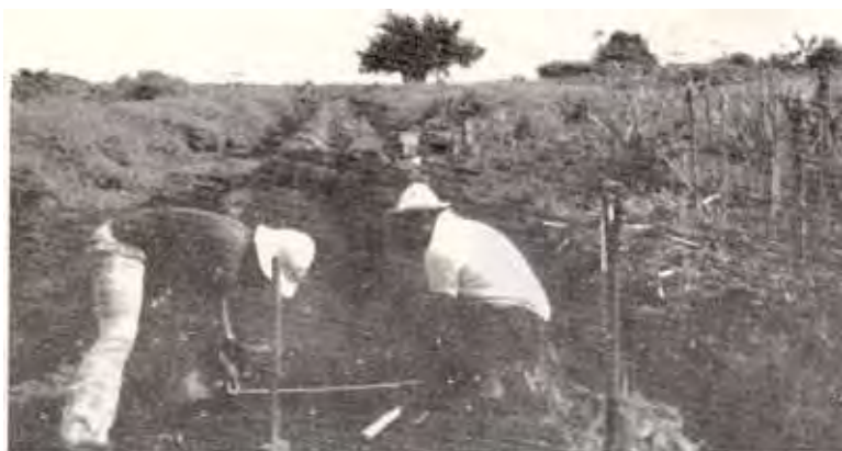
Construcción canal de riego
