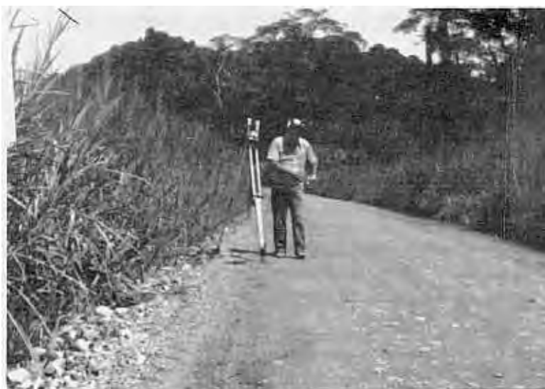
Inicio de estudio de ubicación y levantamiento planimétrico para la nueva Estación Experimental de Bribri en Talamanca, provincia de Limón
