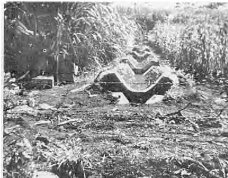
Canal de riego
