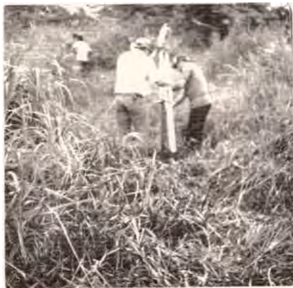
El nivel es colocado para marcar la ruta que el agua ha de seguir para habilitar nuevas tierras a la producción nacional
