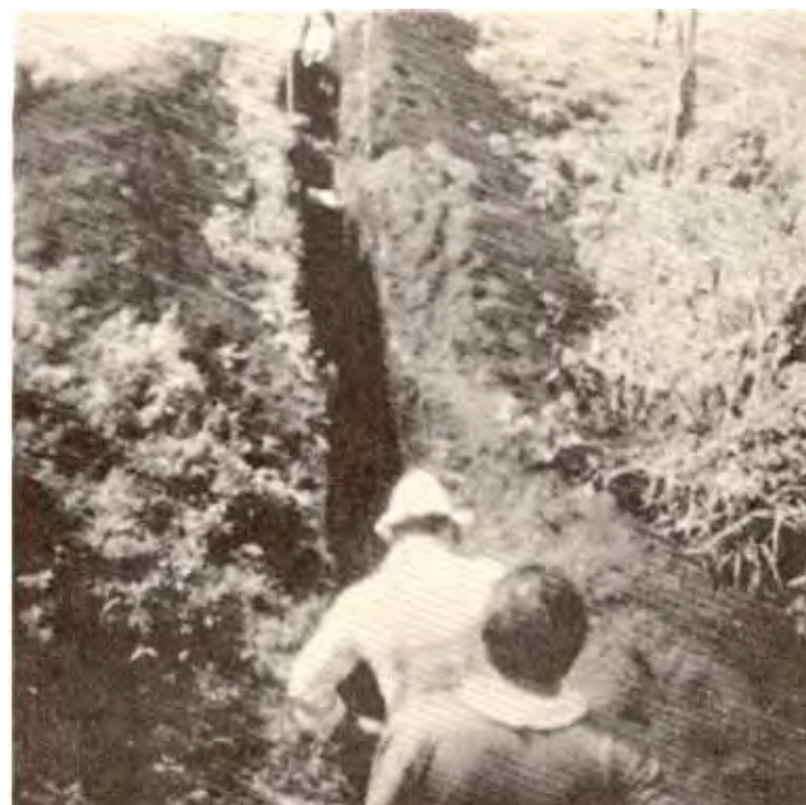
Construcción de zanja para instalación de cañería de conducción de agua para el beneficio de COOPETILA, Arenal
