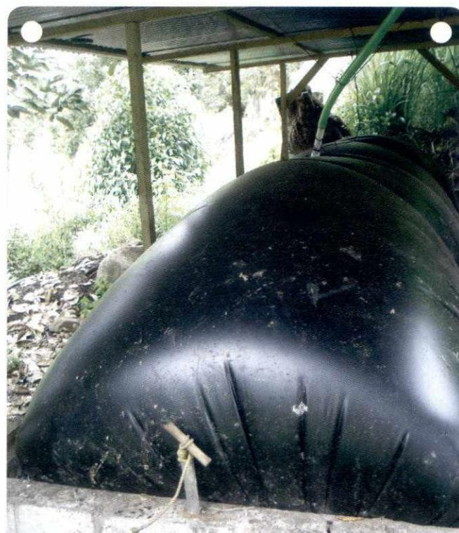
Biodigestor de bolsa protegido bajo techo
