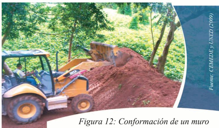
*Figura 12: Conformación de un muro de la represa.*
