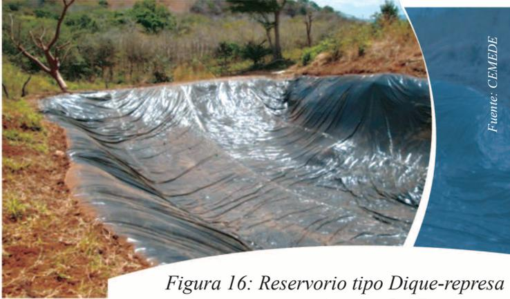
Figura 16: Reservorio tipo Dique-represa con revestimiento plástico, La Esperanza, Santa Cruz.
