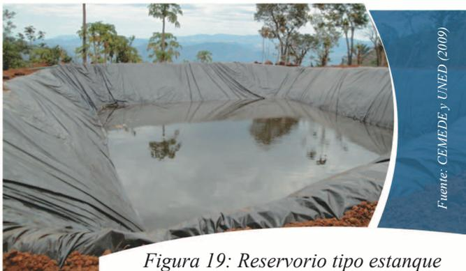
*Figura 19: Reservorio tipo estanque revestido con plástico.*
