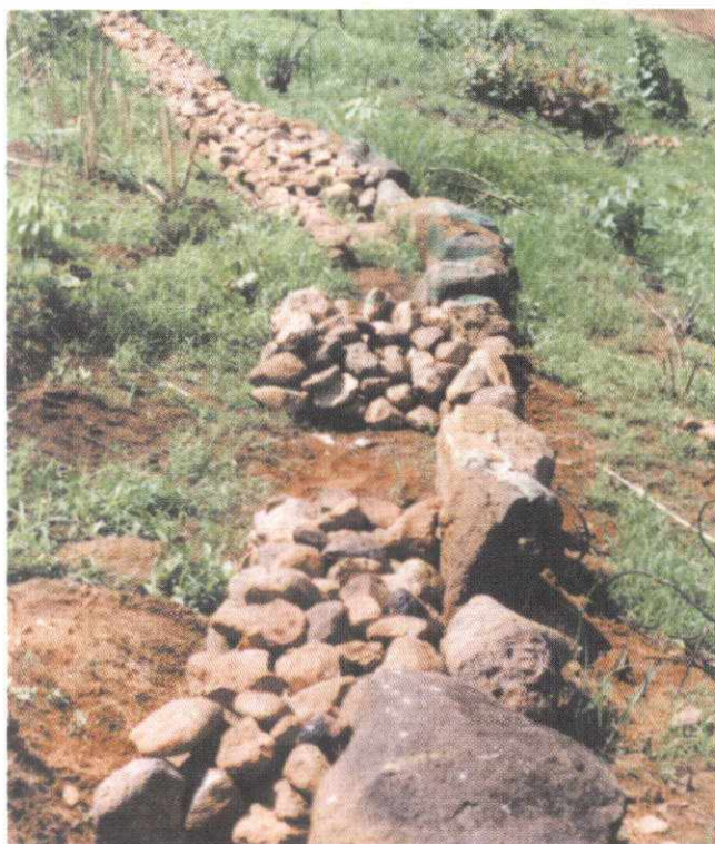
Figura 24. Muro de piedra.
