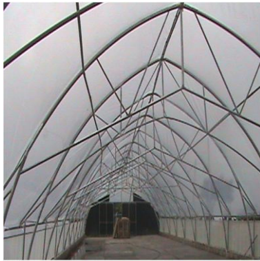
Estructura de techos patios
