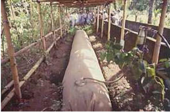
Biodigestor de Bolsa Plástica, 8mt.
