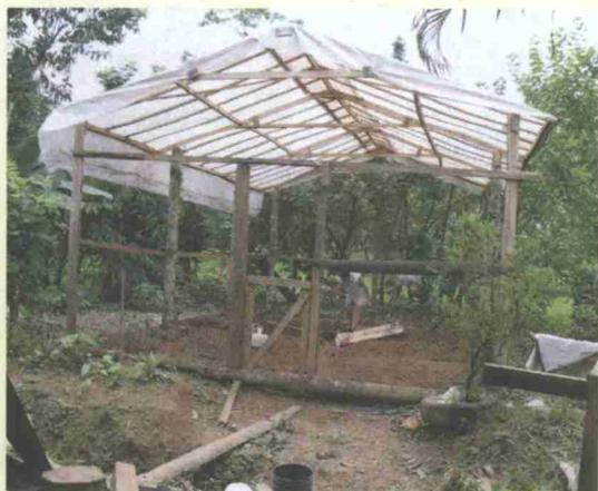
Estas estructuras se colocan en terreno plano, en áreas donde haya el máximo de luz solar y que estén protegidas contra el viento. Se usa plástico de polietileno transparente de baja densidad, el cual se debe colocar en horas frescas del día para que quede debidamente tensado. Las piezas de madera que quedan en contacto con el plástico deben estar lisas para evitar que se rompa.
