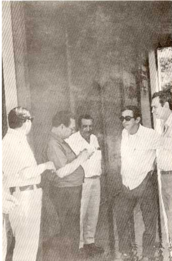
Visita a las cámaras de fumigación que se construyen en la frontera norte. El periodista Oldemar Ramírez toma nota de las características y servicios que prestarán estas cámaras
