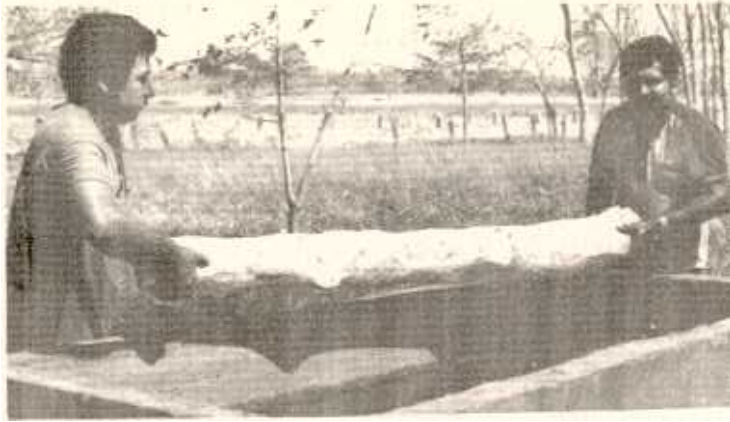
Tanque de tratamiento para postes de cerca en la Estación Experimental Enrique Jiménez N.
