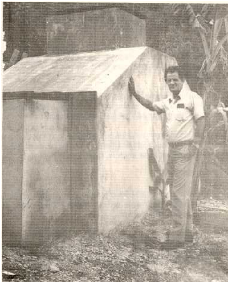
Bio-digestor de cemento armado alimentado con broca de café y agua únicamente. Lugar: Cooperativa de café, Santa Rosa - Heredia
