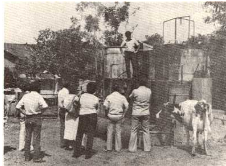
Dos biodigestores, uno de estañones y otro de cemento armado para boñiga
