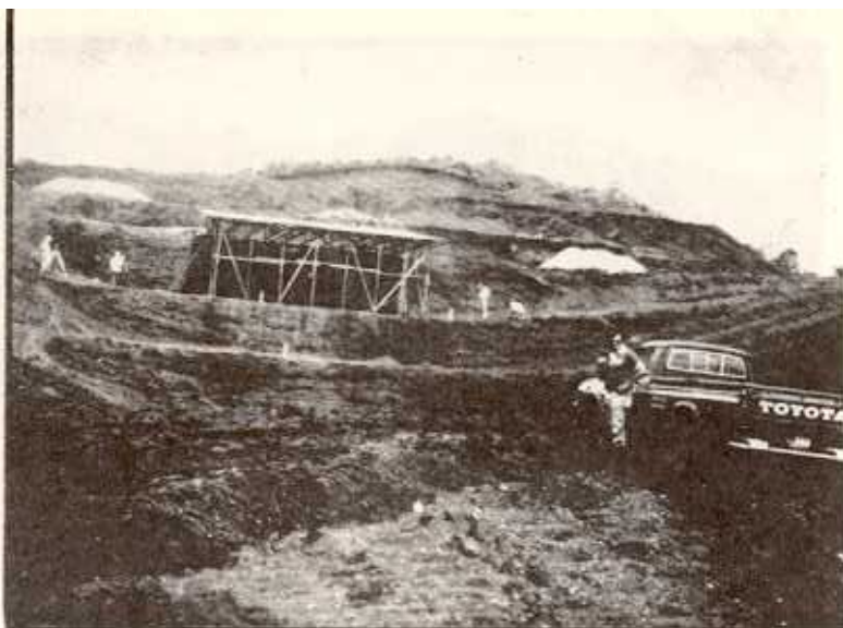
Construcción de terrazas e inicio de construcción de beneficio de café para COOPETILA, Arenal
