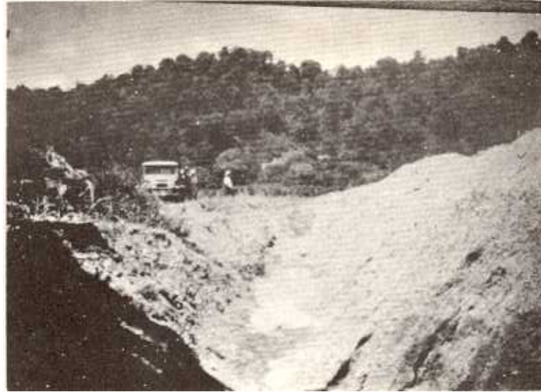
Canal de drenaje en construcción en la Sub-Estación Experimental BRI-BRI
