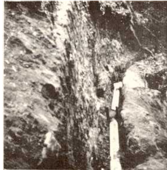
Corte en ladera e instalación de tubería de conducción en 8 pulgadas para suministro de agua al beneficio de COOPETILA, Arenal
