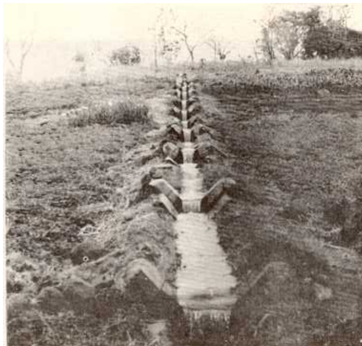
Sistema moderno de conducción de agua de riego en las parcelas del Proyecto de Riego del Río Itiquís
