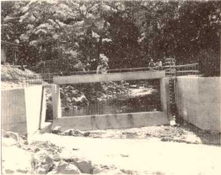
Presa derivadora de Carbonal, Río Itiquís
