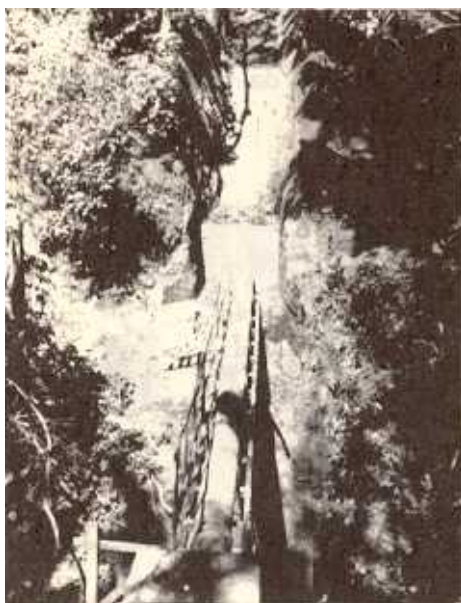
Sistema de conducción entubado en el trasvase Carbonal-Tambor.
