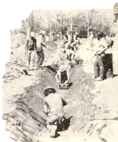
Obras en construcción del trasvase Carbonal-Tambor.
