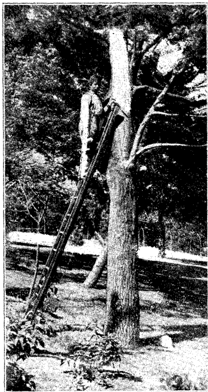
Arbol dañado, que se repara con concreto
