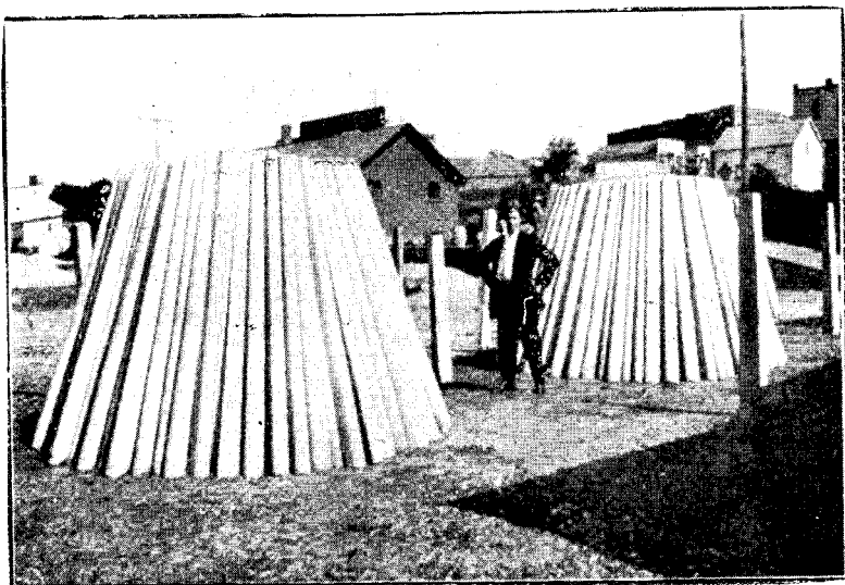
Ejemplo de lo que puede hacerse con concreto. Postes de concreto para cercas constituyen una obra definitiva, que no necesita constantes gastos.
