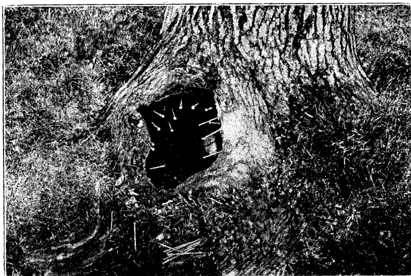
Arbol carcomido, que se salva con llenar la carcoma con concreto
