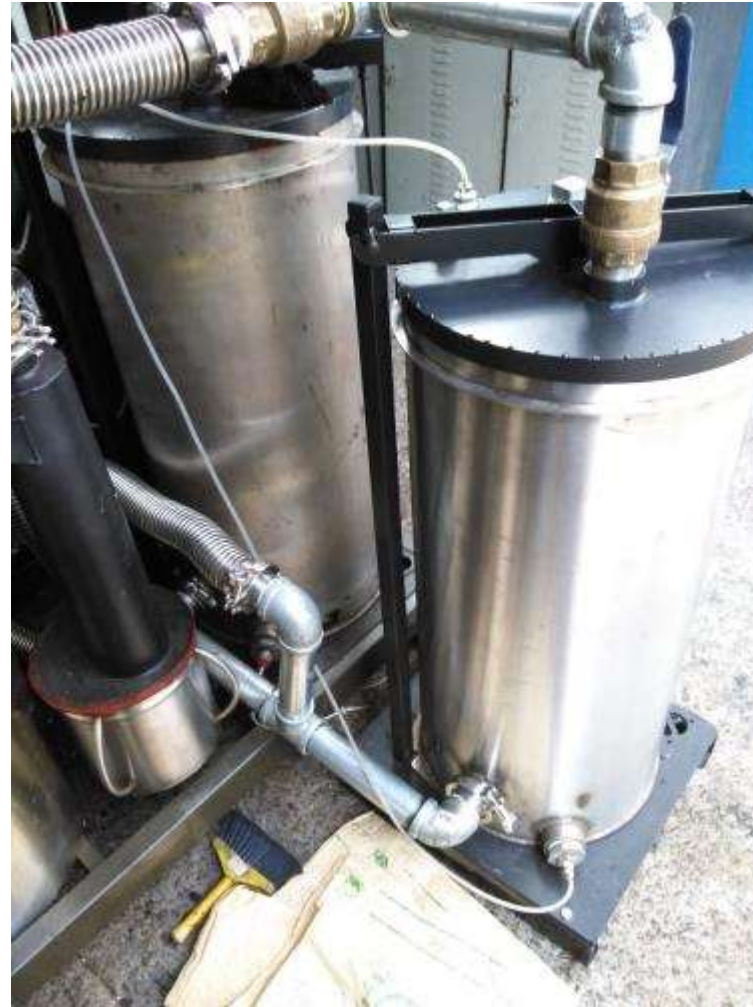
Figura 3.3.3 Instalación del sistema de filtrado en paralelo.
