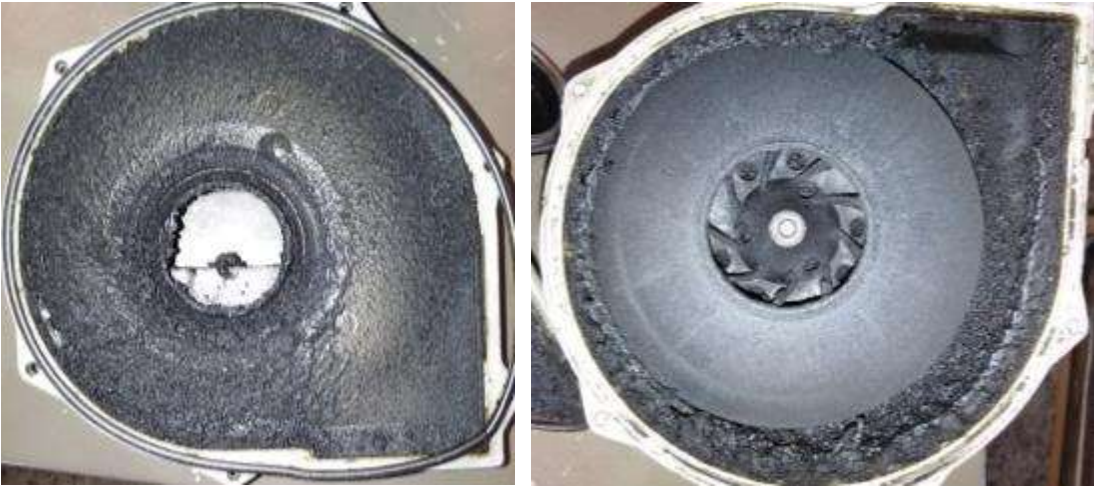
Figura 2.3.1. Ensuciamiento en los sopladores.
