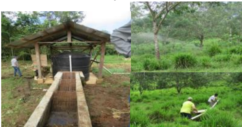
Instalación de sistema de fertirriego en la finca de César Blanco Esquivel
