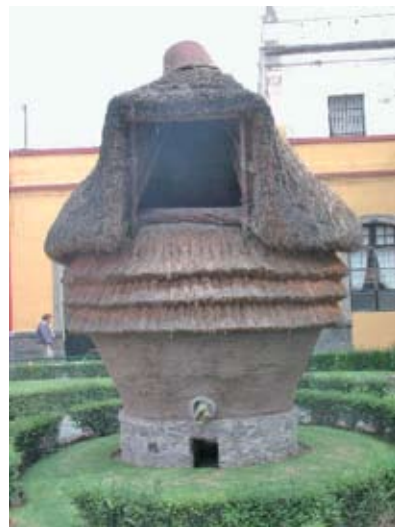
Figura 1. Principios estructurales y funcionales involucrados en el diseño de ambientes protegidos construidos por los aborígenes mesoamericanos, que incluyen alta diversidad arquitectónica, la manipulación del balance de energía, el levantamiento de las estructuras sobre el suelo, la ventilación cruzada, y el uso de materiales aislantes biodegradables, localmente disponibles como barro y zacate. Jardines de la Universidad de Chapingo, México. 2004.
