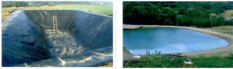
Figura 1. Reservorio en preparación y terminado.
