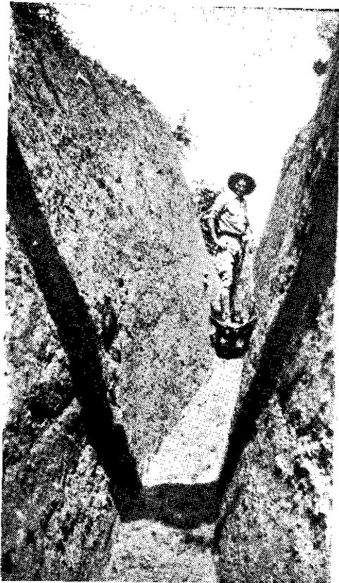
*Véase el ingenio esfuerzo realizado en "Pilón de Azúcar" para saneamiento: corte de drenaje.*
